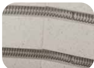
Varmelegemer, monteret beskyttet i riller
